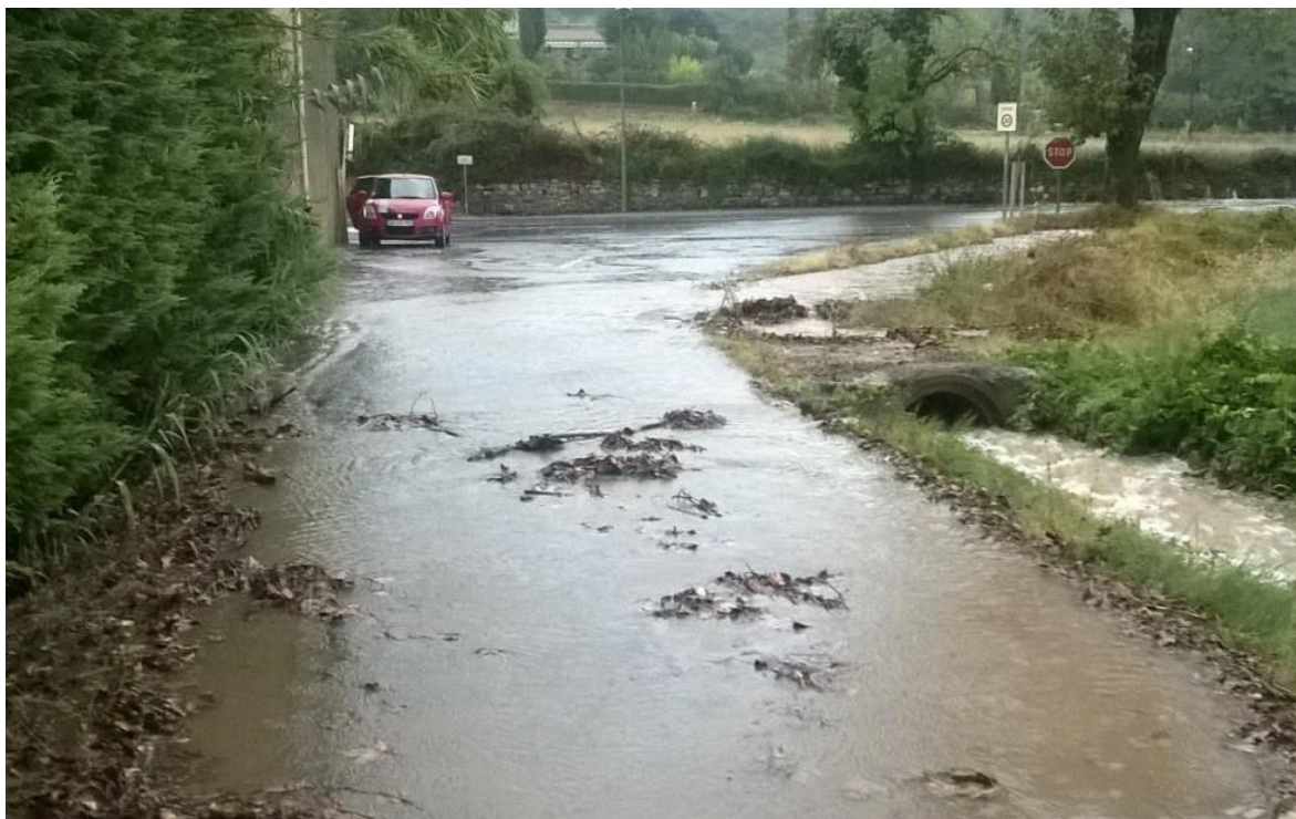
Écoulement du fossé contraint par le merlon et perturbé par la buse, engendrant des débordements vers les maisons et jardins (Automne 2018)
